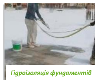
Гідроізоляція на бітумі
