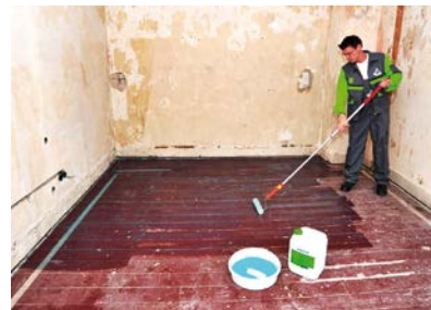
Грунтування дерев'яної поверхні KÖSTER VAP I 06
