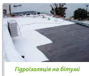
Гідроізоляція балконів / терас
