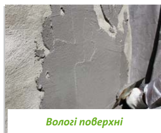
Гідроізоляція фундаменту
