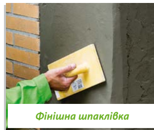
Товстшарове покриття
