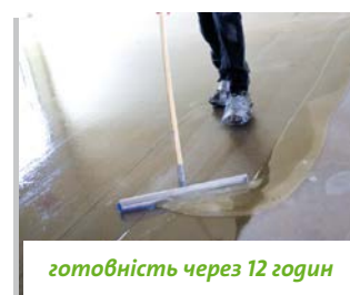
можна використовувати на свіжому бетоні через 7 днів
