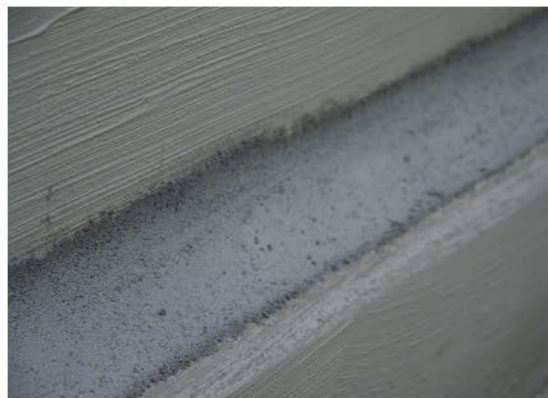
2. Заокруглення кутів з KÖSTER Sperrmörtel WU
