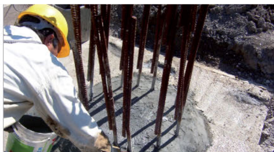
Гідроізоляція оголовка палі з KÖSTER NB 1 grau
