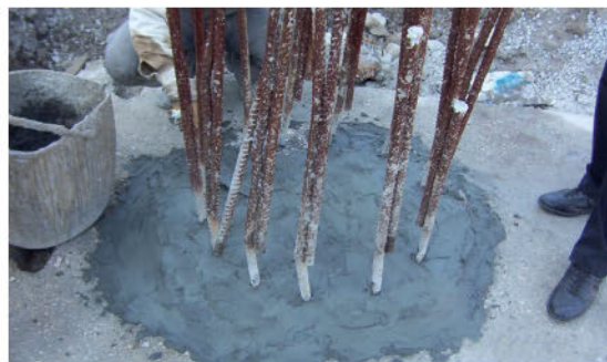
Влаштування заокруглень і вирівнювання поверхні з KÖSTER Sperrmörtel Wu
