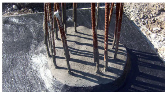
Поєднання гідроізоляції (KÖSTER Deuchan®) поверхні, стиків з герметизацією оголовка палі
