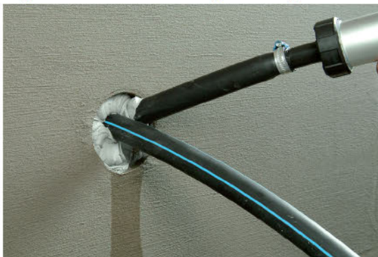
Потім отвір заповнюється з KÖSTER KB-Flex 200 за допомогою ручного пістолету, напр. KÖSTER hand-Pistol
