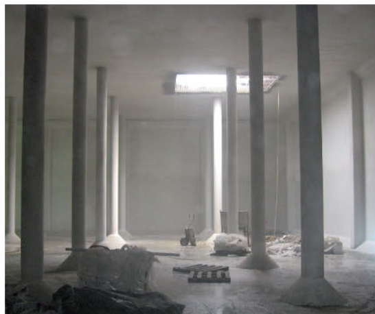
Виконання позитивної гідроізоляції в резервуарі з KÖSTER NB 1 KÖSTER NB 1
