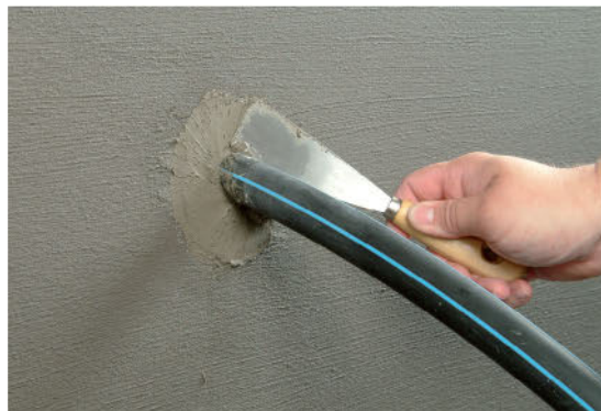
Тепер місце входу комунікацій водонепроникне. Для гідроізоляційного захисту, ділянка навколо труби або кабелю додатково обробляють за допомогою KÖSTER KB-Fix 5
