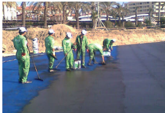
Гідроізоляція з KÖSTER Deuxan®
