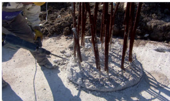
Зніміть надлишок бетону та очистіть поверхню
