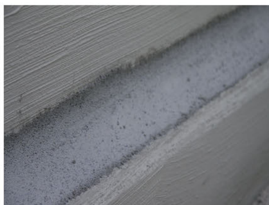
Заокруглення на стику бетонної стіни та підлоги з KÖSTER Sperrmörtel WU
