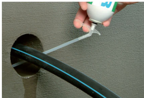
Перед нанесенням KÖSTER KB-Flex 200, в отвір ін'єктується Pu-Schaum (поліуретанова піна)
